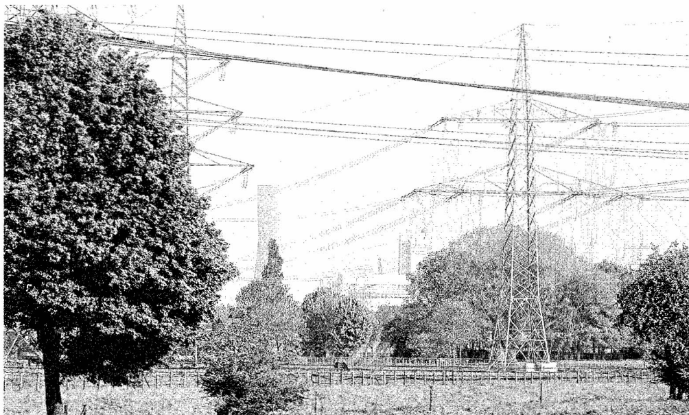
Die vom BUND kritisierte Starkstromtrasse verbindet das Trianel-Kraftwerk mit der Schaltanlage Waltrop. Sie verläuft überwiegend auf Waltroper Stadtgebiet.
